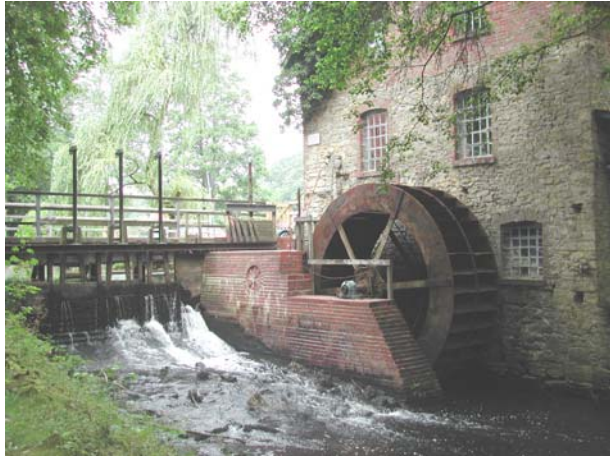
historische Wassermühle - Entfernung ca. 80 m
