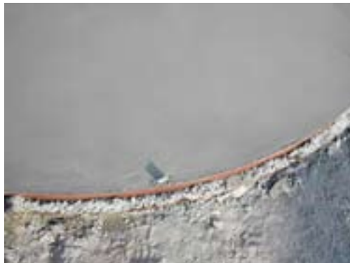
Anker zur Befestigung der Banden werden in den frischen Zement gedrückt
