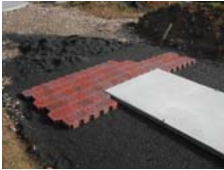
Vorbereitung der Pflasterfläche mit Granulat – verdichten und abziehen
