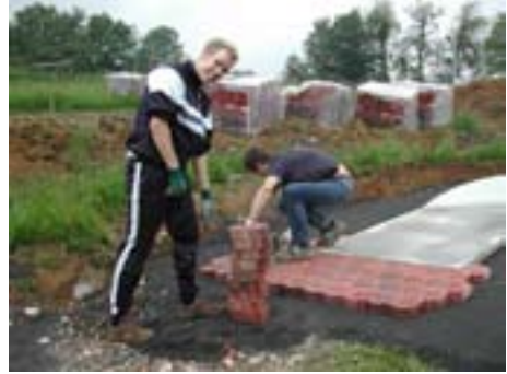
Legen der Pflastersteine
