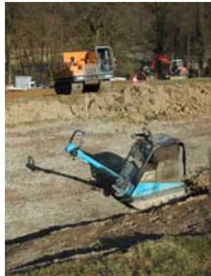
Fundamente verdichten
