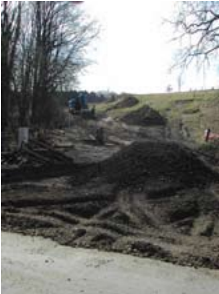
Anlegen einer Baustraße
