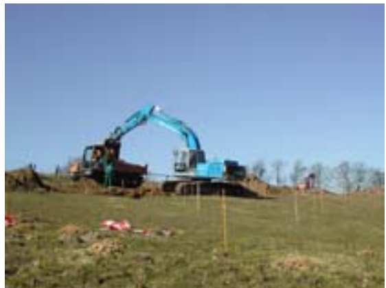
Lage der Bahnen mit Holzpflocken, Flutterband und Sprühfarbe markieren
