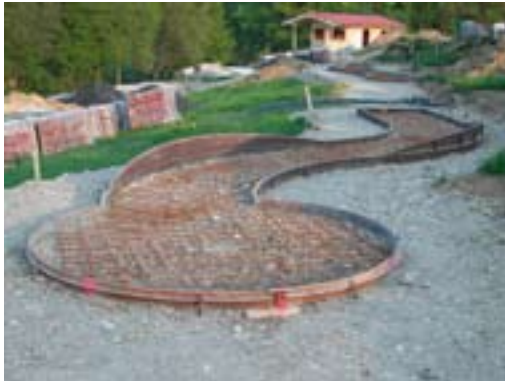
Aufbau der Gießformen auf den verdichteten Fundamenten
