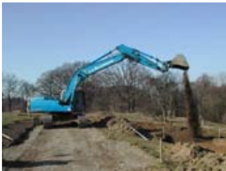
Fundamente der Bahnen legen
