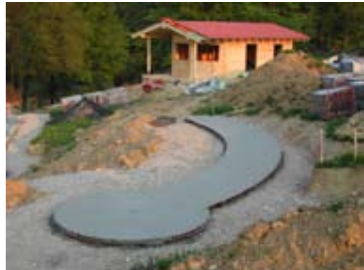
Gießen der Spielflächen – zehn Zentimeter Zement und zwei Zentimeter Estrich
