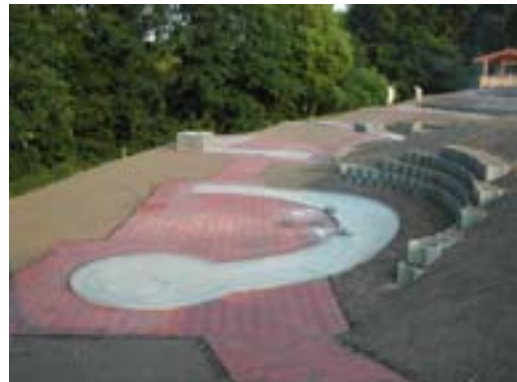
Befestigung der Banden an den Ankern und Aufbringen der Abschlagkreise, Hindernis- und Ablegelinien
